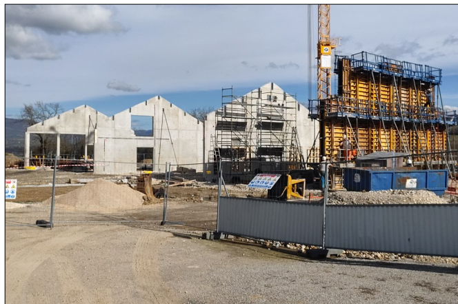
Les travaux du futur bâtiment se poursuivent
