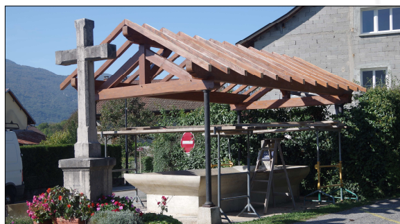
Le lavoir du fond du village pendant les travaux
