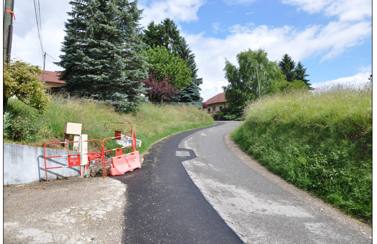
Fin des travaux d'enfouissement sur la Route du Pré Lachat
