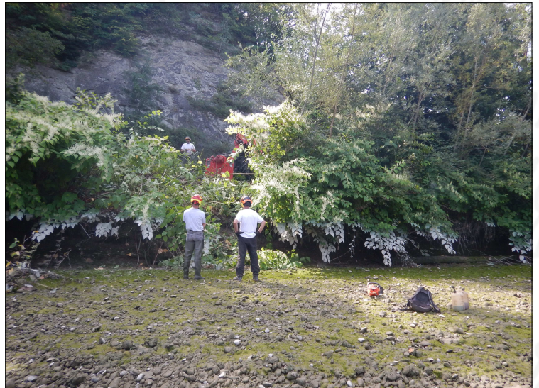
Travaux d'entretien sur le secteur de Bassy
