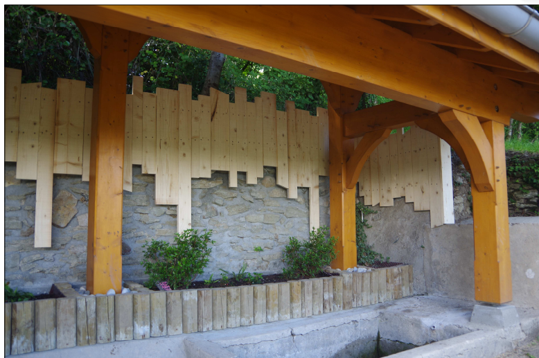
Travaux réalisés sur le lavoir de Veytrens
