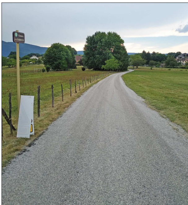
Revêtement bicouche appliqué sur le chemin de la Charbonneuse
